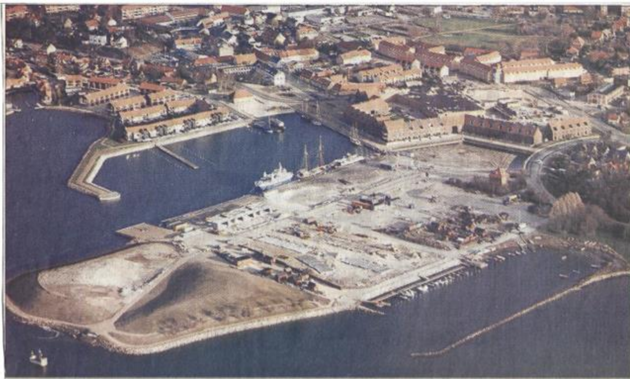
Dette aktuelle luftfoto viser, at Frederikssund forandrer ansigt mod fjorden fra dag til dag. På Sydkajen nederst i billedet ses de første af betonelementerne til Kuben Bygs boligbyggeri langs havnefronten. Foto: Profil Luftfoto v/ Gert Broxgaard
